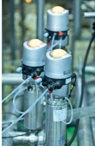
Tête de commande universelle type 8681 sur différentes vannes process hygiéniques.
