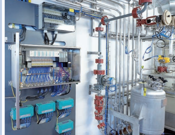
Installation sur site
